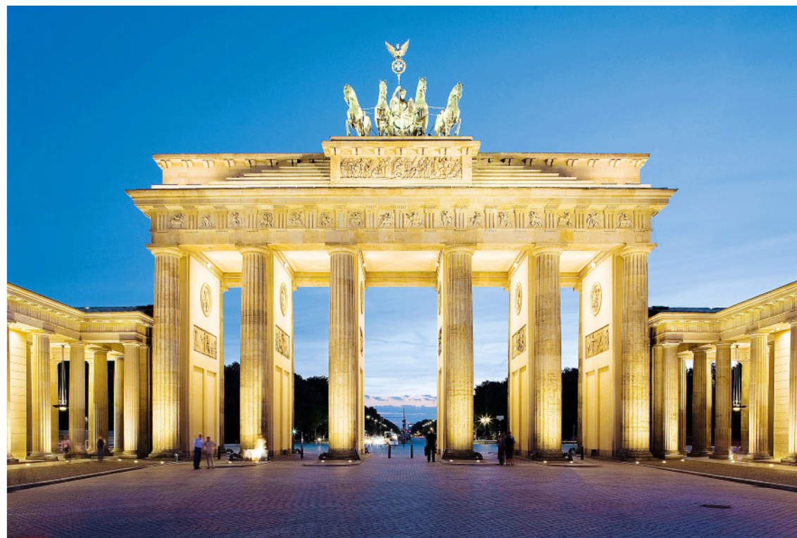
La porte de Brandebourg à Berlin, endommagée en 1945, restaurée après 1990. Massimo Ripani/SIME/4Corners
